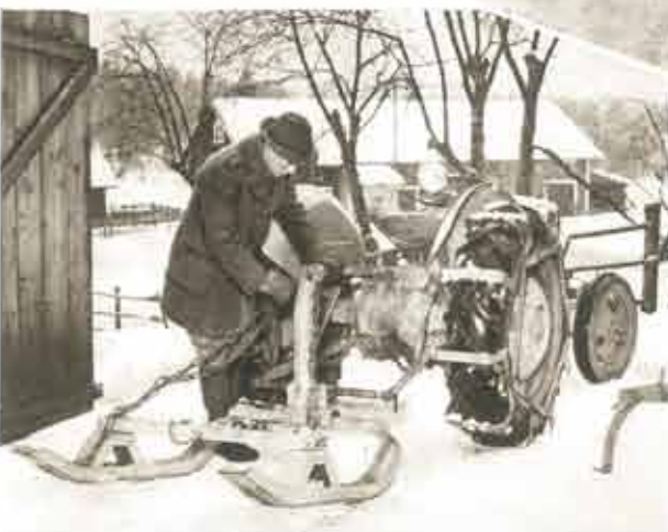
Markberedningen i skogen kan nu även utföras med till hjultraktorn kopplad skogskultivator, varvid mycken arbetstid inbesparas.
